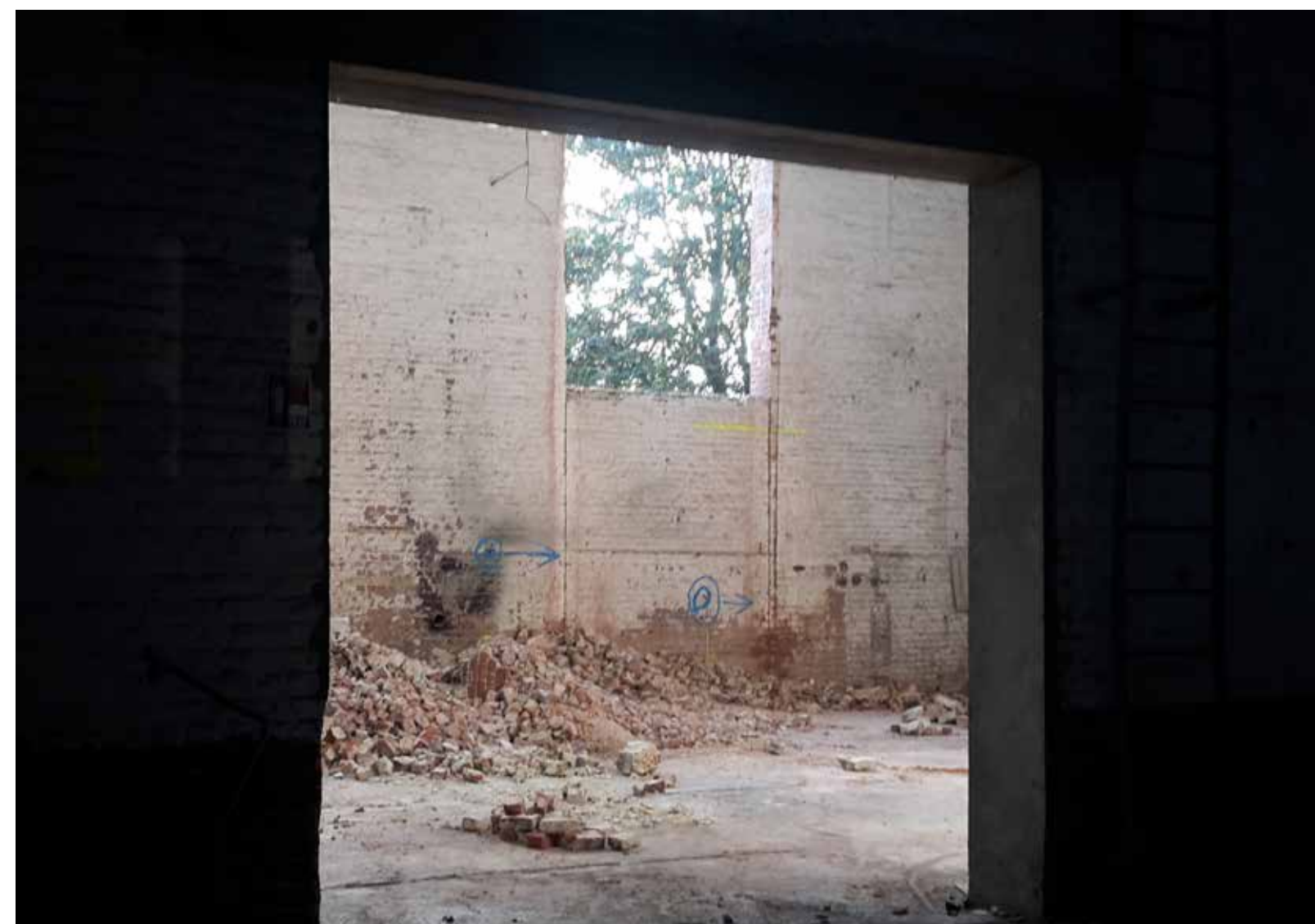
▲ Les consoles en béton préfabriquées insérées à mi-hauteur des baies servent à chaîner la façade et à recevoir le nez du nouveau plancher intermédiaire. Les achelets s'apprêtent à recevoir la future charpente.
